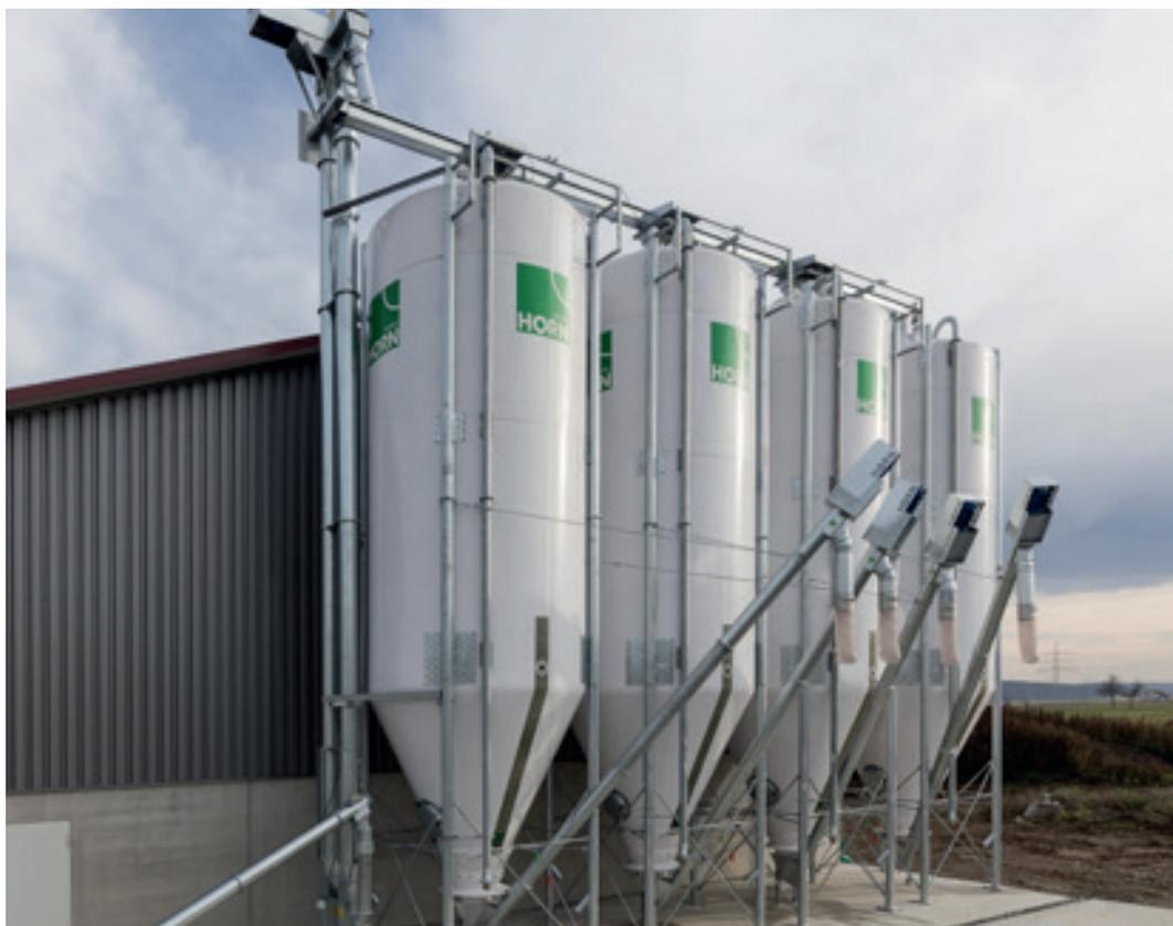
GFK Silos mit Siloentnahmeschnecke
