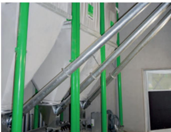
Trevira Silo mit Entnahmeschnecke
